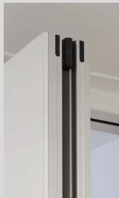
*Plinthes télescopiques en aluminium (partie supérieure noire) + profil femelle en aluminium*
