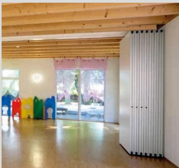
*Stockage des éléments d'un mur mobile à rangement type Z8. Le type de rangement est optimisé en fonction de la forme et de l'espace disponible de la pièce.*
